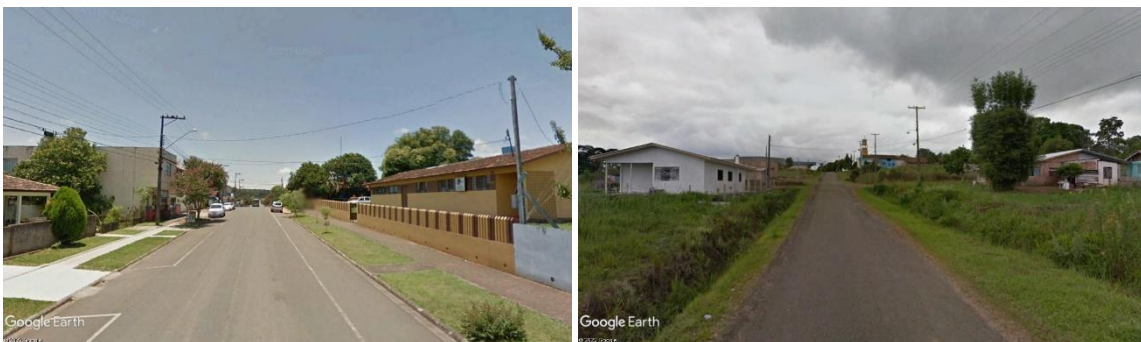
Fotos 01 e 02. Rua Agostinho de Souza, em bom estado de conservação e Rua São Carlos, carente de manutenção e sinalização viária. Fonte: Google Earth.
