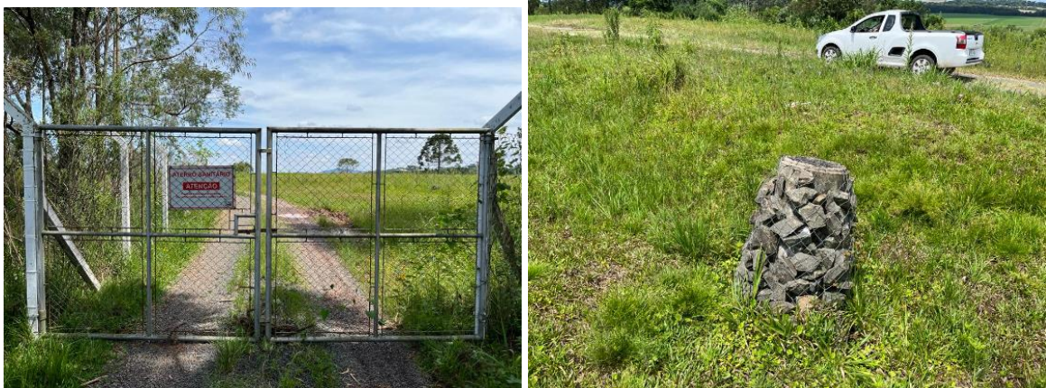
Figura 21 – Aterro sanitário de Paula Freitas (processo de encerramento)
